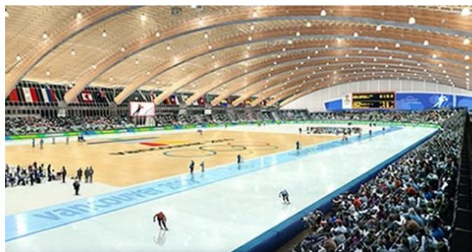
ством кровельных панелей путем подготовки и отправки данных для станков с ЧПУ, которые были разработаны специально для этого проекта.
