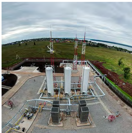
Система приема, хранения и регазификации сжиженного природного газа. Пермский край
