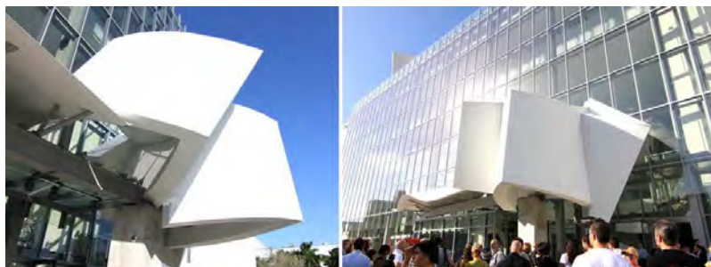
Рис. 2-1-14. Высшая музыкальная школа New World Symphony: главный вход. Архитекторы Gehry Partners, 2010
