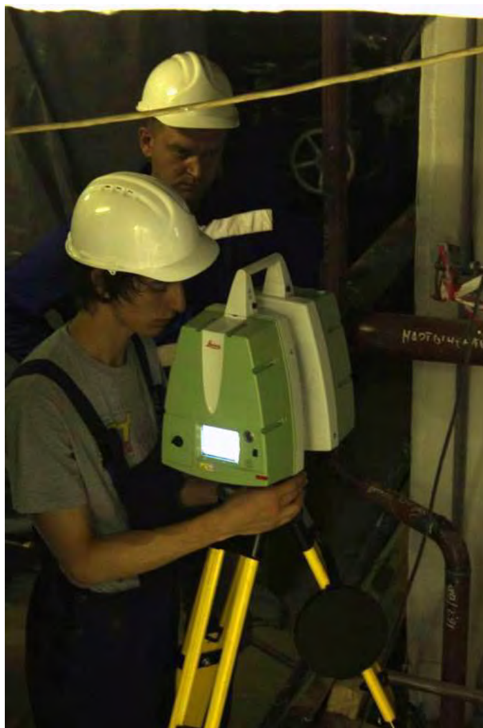
Рис. 7. Установка 3D лазерного сканера на штатив
