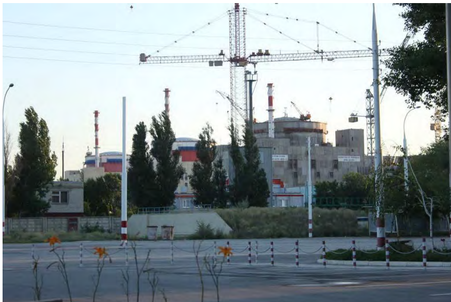
Рис. 4. Строящийся энергоблок № 3 Ростовской АЭС.
