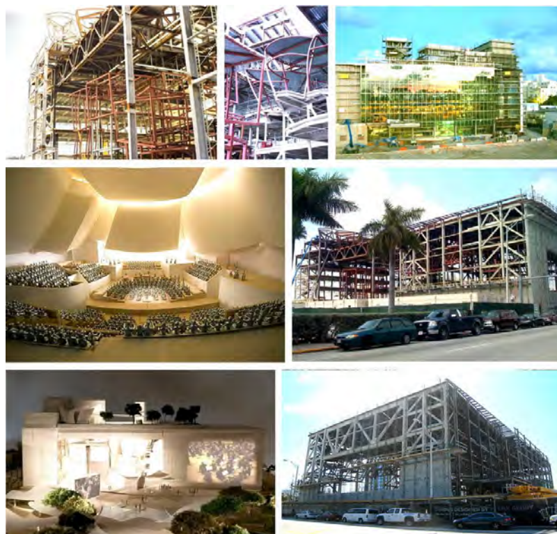
Рис. 2-1-13. Строительство нового здания американской высшей музыкальной школы New World Symphony и его будущий внешний и внутренний виды
