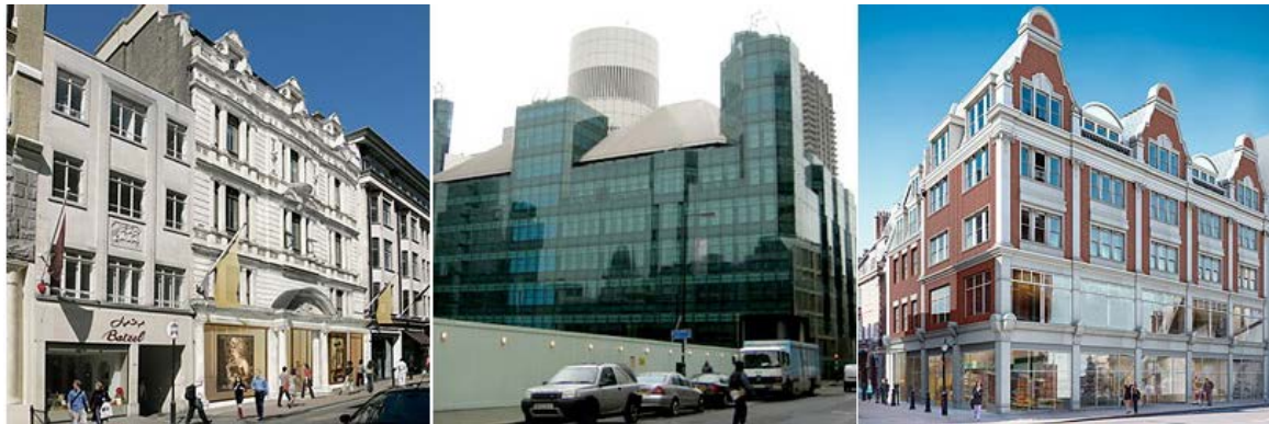
Ramboll: проекты обновления зданий и фасадов
