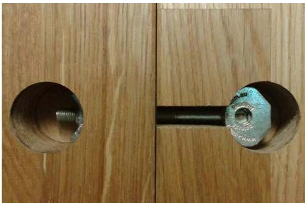
Зачастую посадочные пазы под крепеж также имеют сложную составную форму.
