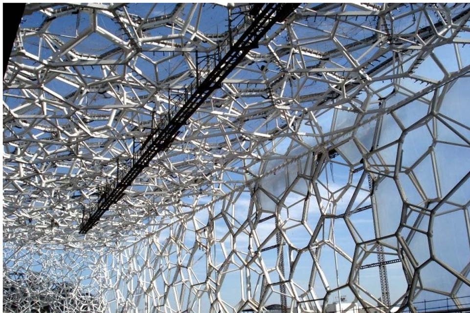
Рис. 17. «Водный куб»: конструкции основного каркаса здания.
