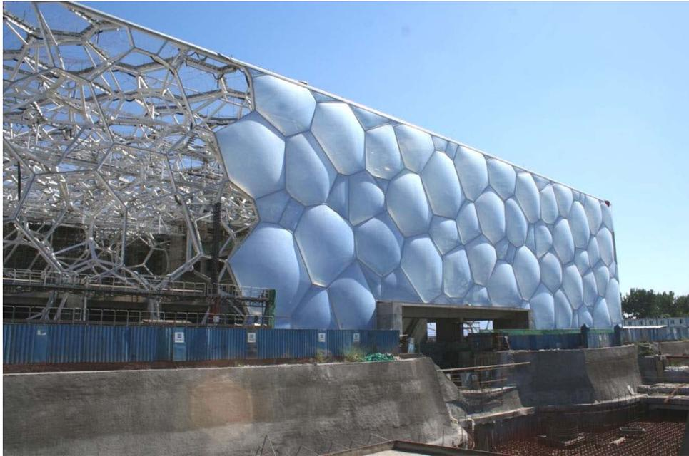
Рис. 15. Монтаж стен из «пузырьков» при строительстве Водного стадиона. Слева видны открытые конструкции несущего каркаса.
