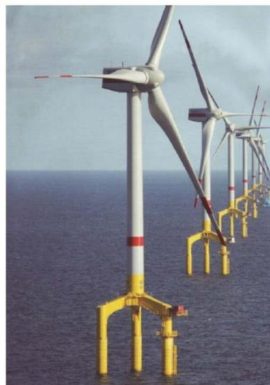
Рис. 7 Опорное основание морского ветрогенератора
