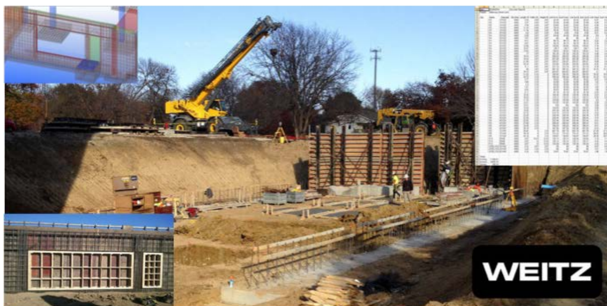
Рисунок 6. Джаред Шлейфер, Weitz Company/США: "Моделирование при проведении бетонных работ означает новое качество проектирования. Более чем вероятно, что вы найдете детали, которые бы никогда не заметили при работе с чертежами без программного обеспечения".
