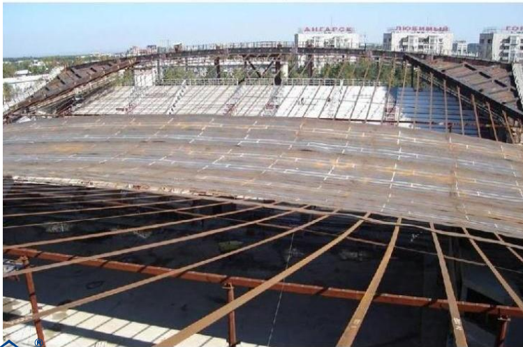
Рис. Б. 5.6. Раскладка полотнищ мембраны по временным элементам «постели».
