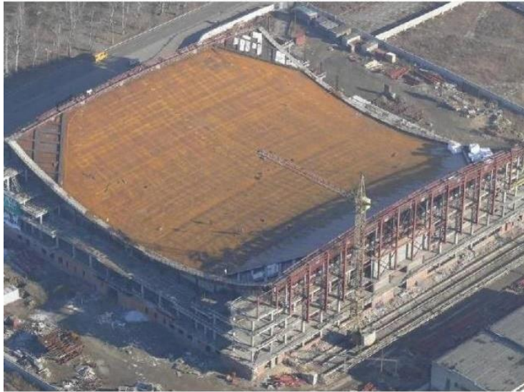
Рис. Б. 5.16. Законченное мембранное покрытие. Вид на объект сверху.
