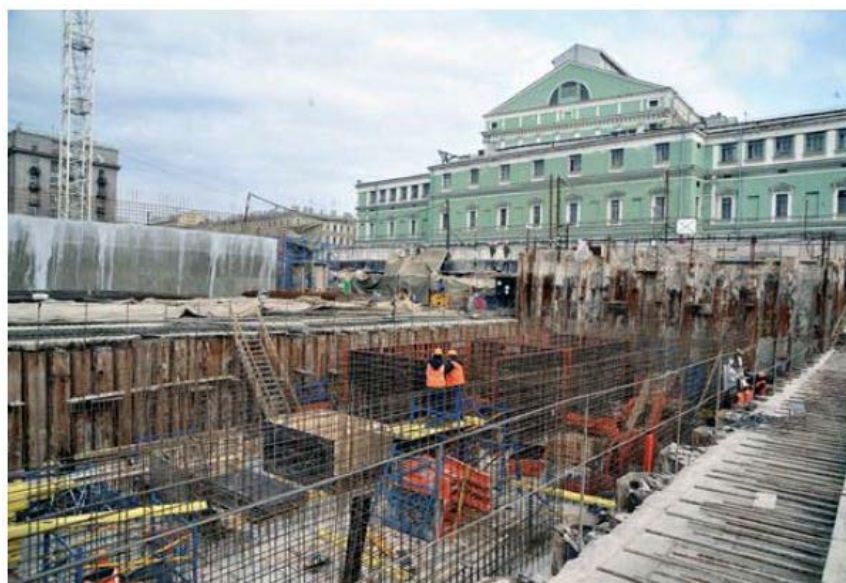
Работы по возведению ст. «Театральная» ведутся в условиях плотной городской застройки
