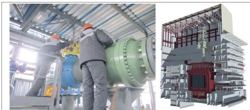
Рис. 1. Правильная оценка 3D-модели позволяет оценить и организовать необходимый доступ к месту ремонта
