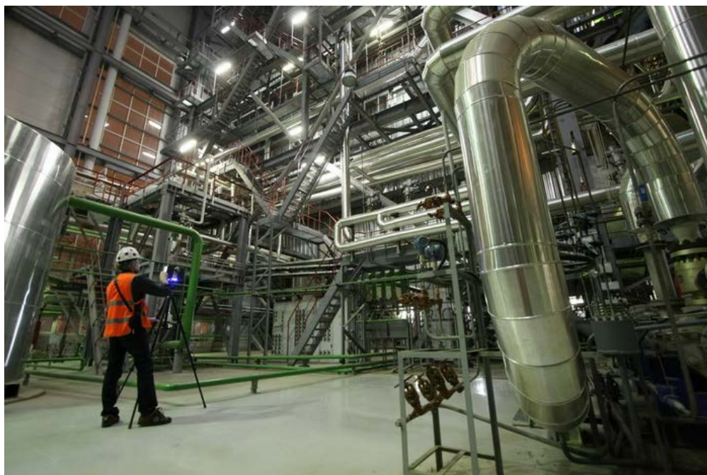
Рис.1. 3D лазерное сканирование Юго-Западной ТЭЦ
