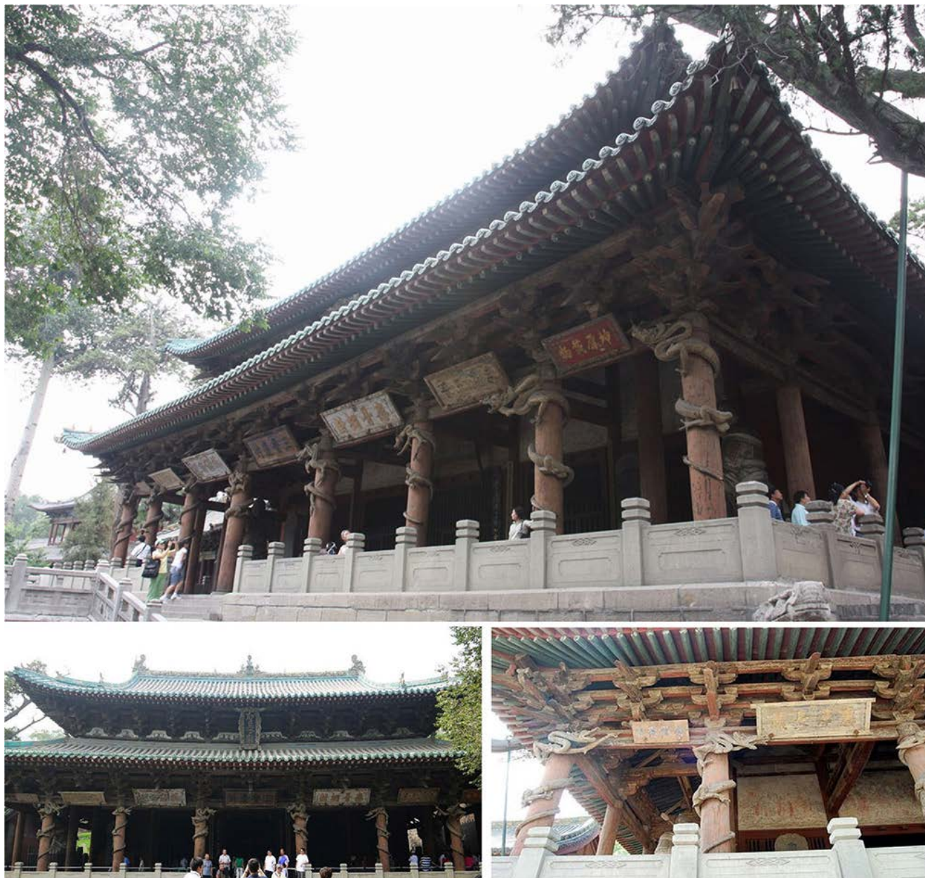
Рис. 2. Храм Шенмудянь (1102 — 1106) в монастыре Цзиньцзы в провинции Шаньси — один из дошедших до нас деревянных памятников архитектуры, построенных с помощью доугун.
